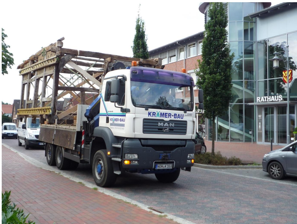
Transport des Fachwerks
