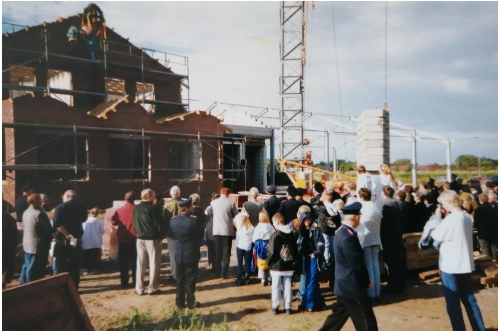
Richtfest des neuen Feuerwehrhauses und DRK Heimes (18.08.1999)
