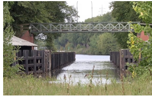
Alte Fahrt Schleuse
