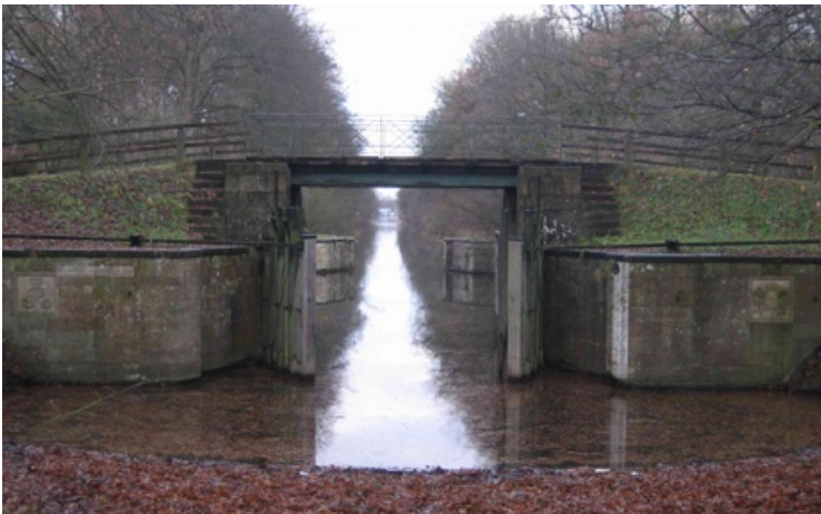
Süd Tor der Schleusenanlage in Lingen
